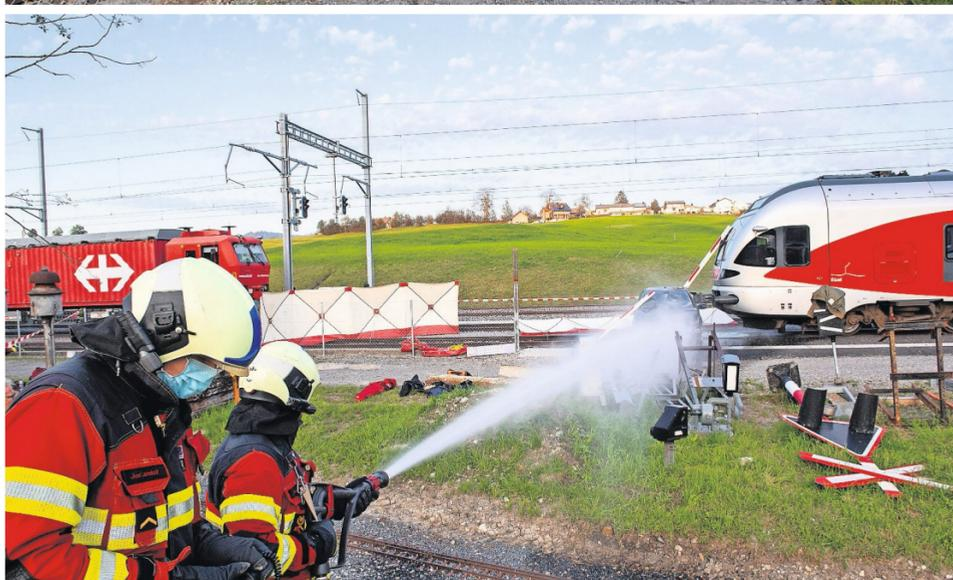
Alles abgesperrt (Bild oben). Brandbekämpfung mit Wasser ist auch im Zusammenhang mit dem Bahnstrom korrekt. Allerdings müssen die Feuerwehrleute einen Mindestabstand einhalten, damit der Strom nicht leitet.
