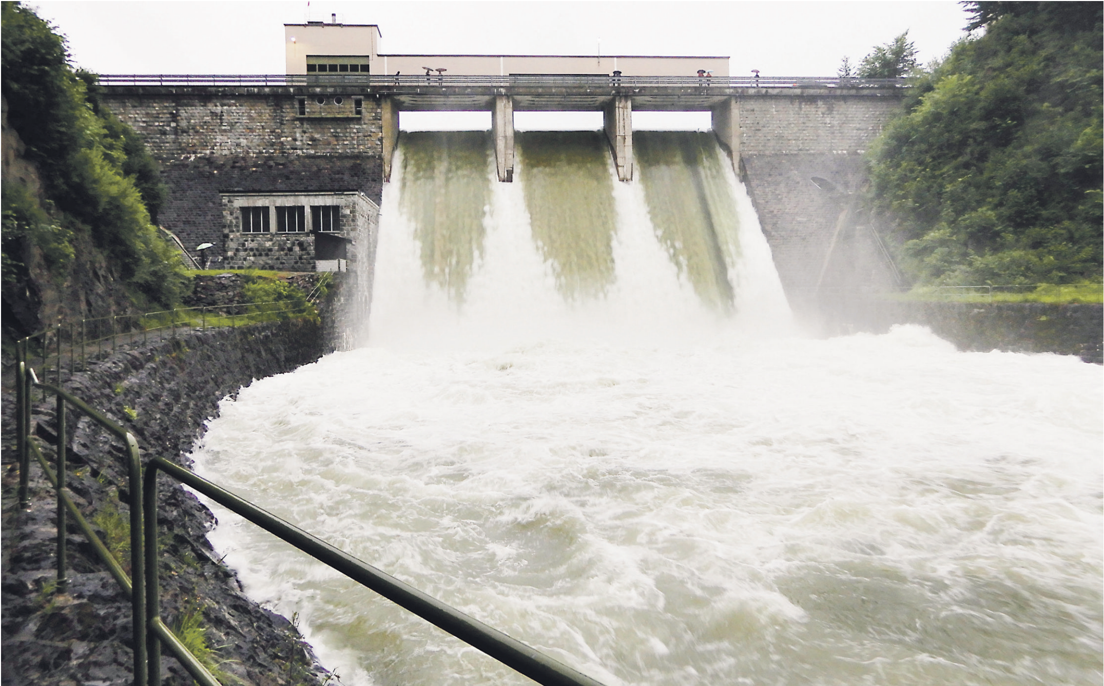
Ein solches Spektakel beim Staudamm Schlagen beim Sihlsee gibt es nur selten zu sehen. Das gestaute Wasser wurde vorsorglich kontrolliert abgelassen, damit der flächenmässig grösste Stausee der Schweiz wieder Kapazität hat, um stärkere Regenfälle aufzufangen. Foto: Wädi Kälin (Gross)
