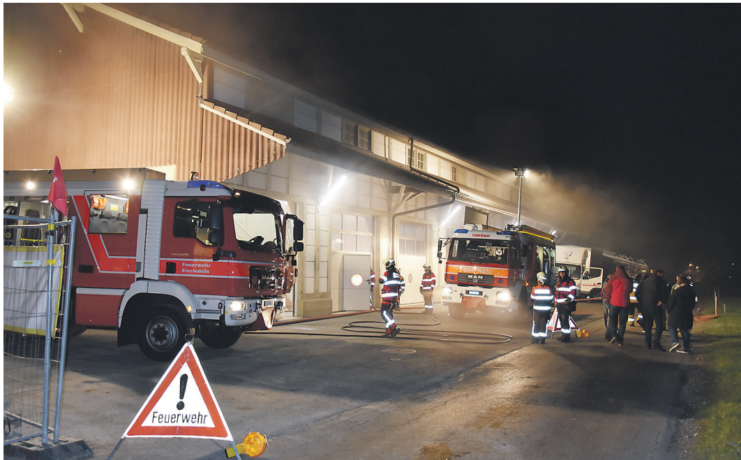
Im neuen Werkhof fing ein Zimmer Feuer und musste durch die Einsatzkräfte gelöscht werden. Foto: René Hensler
